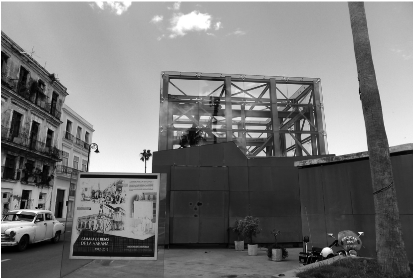
Fotografía 4. Cámara de rejas de La Habana, Cuba.
